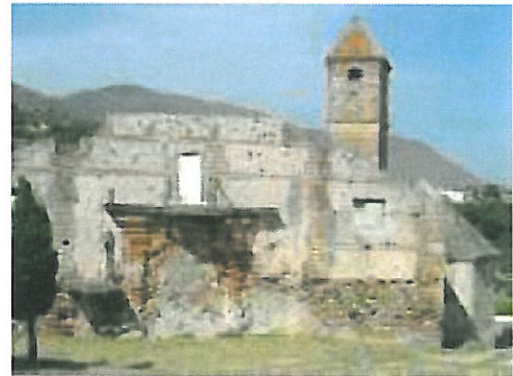
El edificio quedó en ruinas.
